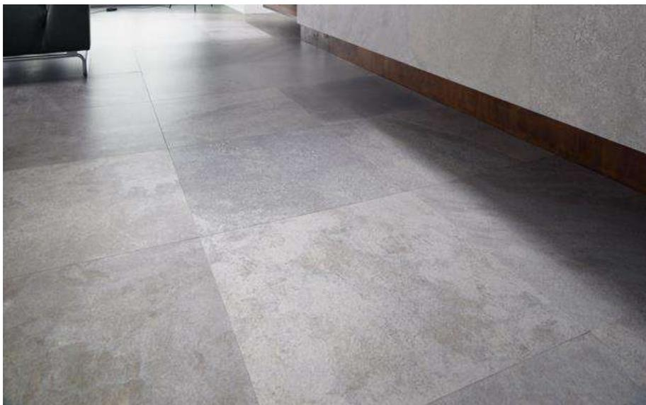
*Ilustración 16. Aspecto de pavimento de gres porcelánico de gran formato*
