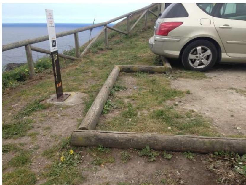
**Fotografía 7.** Ejemplo de aparcamiento en tierras y delimitación horizontal mediante traviesas de madera.
